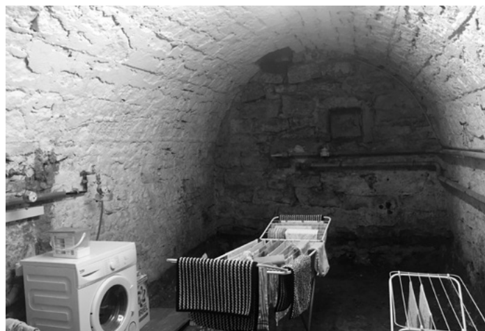
写真3：アパートの地下の洗濯室
