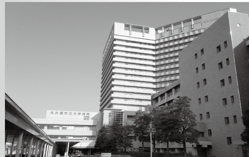
名古屋市立大学病院。18階建ての高層ビルで、下が外来や手術室、7階以上が病棟です。
